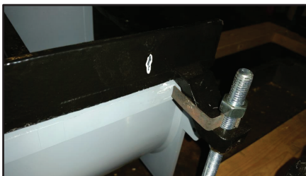
El sujetador en el marco DI de 12 pulg. (30 cm) se conecta con el canal contra el borde superior.
