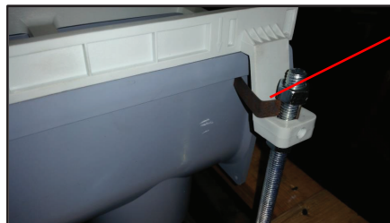
El sujetador en el marco Poly de 6 pulg. (15 cm) se conecta con el canal contra el lado debajo del borde.
