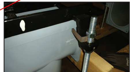
El sujetador en el marco DI de 6 pulg. (15 cm) se conecta con el canal contra el lado debajo del borde.
